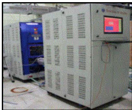
चित्र A.6(a): RRCAT में HTS-2 के लिए 32 kW, 650 MHz SSPA
