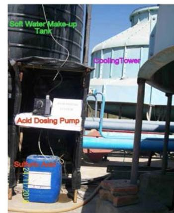
*Fig. 8: Acid dosing system.*
