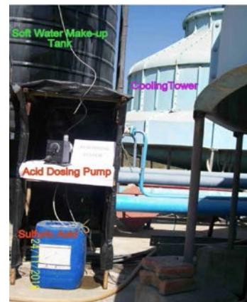
*Fig. 8: Acid dosing system.*
